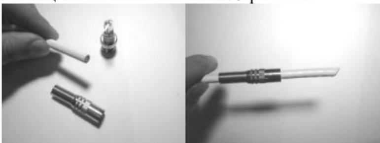
Сделайте надрез изоляции на 10-12 мм от края кабеля. Снимите изоляцию, расправьте оплетку и фольгу
